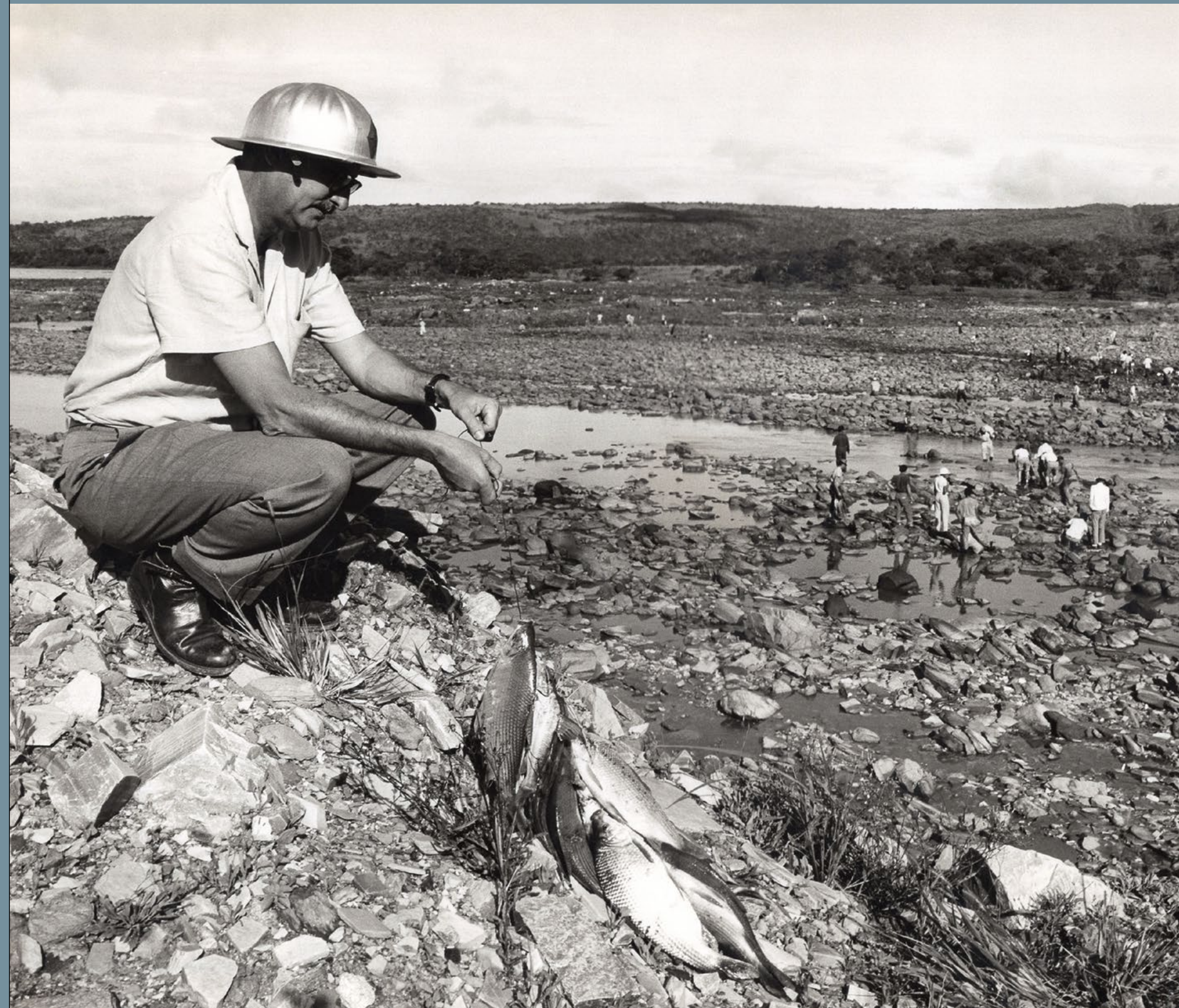
John Cotrim no leito do rio Grande após a abertura dos túneis de desvio, 9 de janeiro de 1963.
