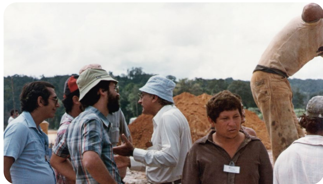
Dois momentos da construção da barragem de Balbina no Amazonas. Na primeira, Victor com o engenheiro geotécnico da ELETRONORTE Cláudio Santos Herkenhoff (de barba). Na segunda, com o geólogo Roberto Correa.
