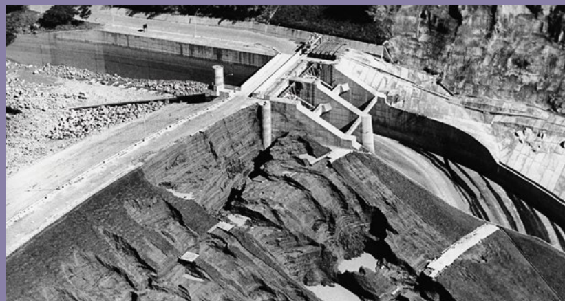
Cenas do acidente em Euclides da Cunha: acima, casa de comando e banco de transformadores; situação do vertedouro; vista tomada da ombreira esquerda; à esquerda, reservatório; à direita, taludes de jusante; abaixo, brecha aberta na extremidade direita do maciço de terra junto à ombreira; situação das comportas; e vertedouro visto de jusante.
