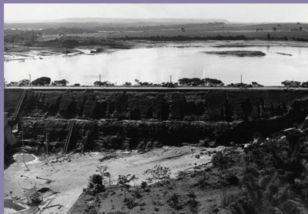
Situação em Limoeiro após o rompimento: no alto, vista da ombreira esquerda com detalhe do talude do montante da ombreira esquerda; talude de jusante (ombreira esquerda); brecha aberta na ombreira direita do maciço; à esquerda, vista de jusante da brecha aberta no reservatório; à direita, erosão devido ao galgamento do talude de jusante do maciço no seu lado esquerdo; e abaixo, ponte danificada à jusante de Limoeiro (antiga ligação Casabranca-Mococa).
