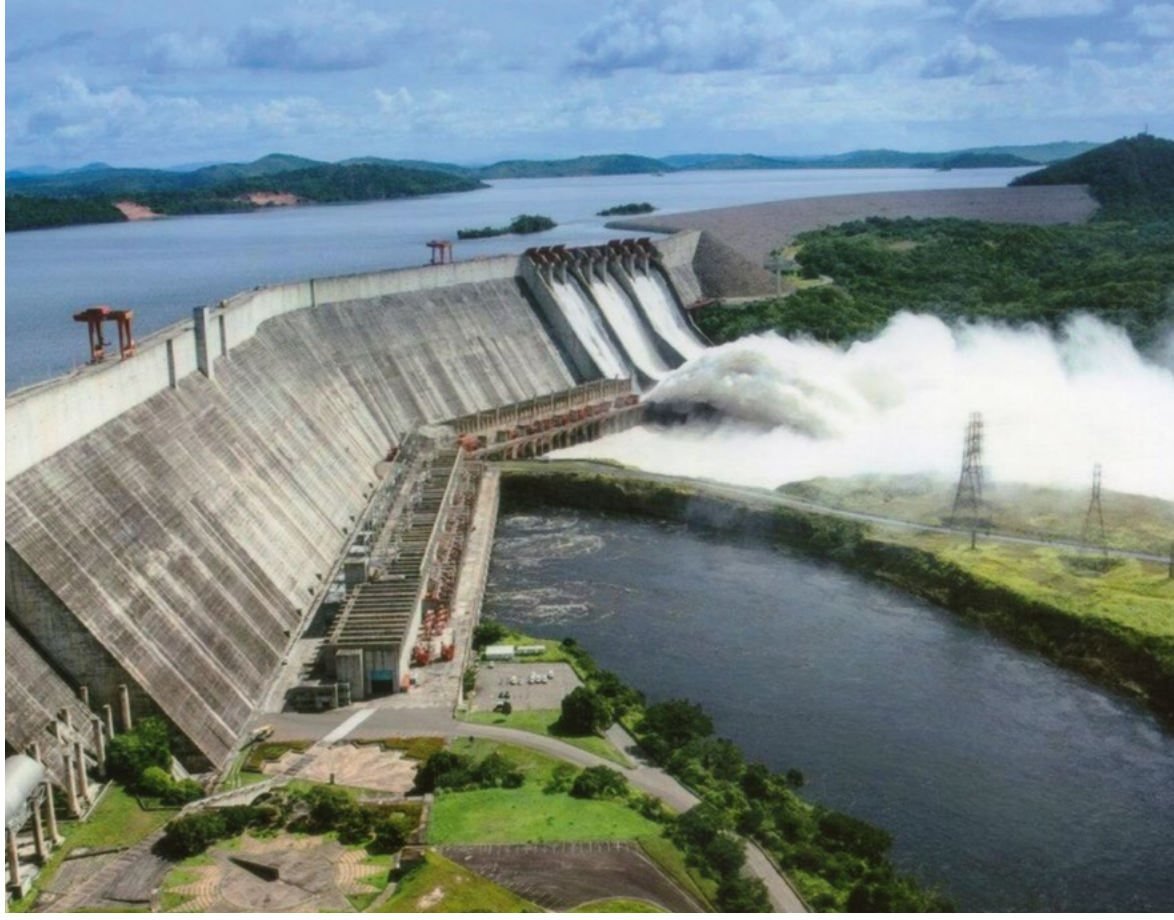
Barragem de Guri, no rio Caroni, Venezuela, é hoje a quarta do mundo. Guri dam, on the Caroni River, Venezuela, now the world's fourth largest.
