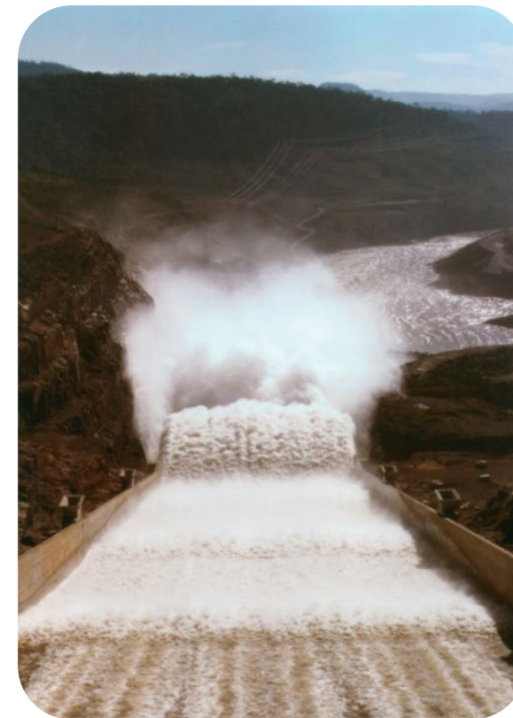
Testes iniciais de aerção do vertedor (duas fotos à esquerda), em Foz do Areia, novembro de 1980. Reportagem sobre Foz do Areia, Dirigente Construtor , abril de 1981. Bayardo Materón e Brasil Pinheiro Machado (assinalados), Victor, Maria Luiza, Barry Cooke e o geólogo Prof. Pedro Marques, apelidado de Pedro das Pedras (assinalado), na barragem, anos 1970.
