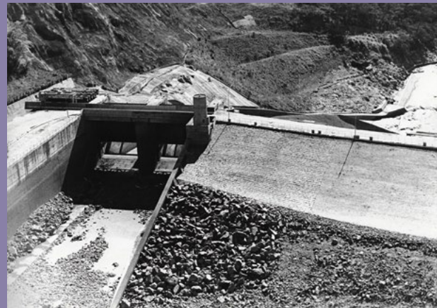
Cenas do acidente em Euclides da Cunha: acima, casa de comando e banco de transformadores; situação do vertedouro; vista tomada da ombreira esquerda; à esquerda, reservatório; à direita, taludes de jusante; abaixo, brecha aberta na extremidade direita do maciço de terra junto à ombreira; situação das comportas; e vertedouro visto de jusante.
