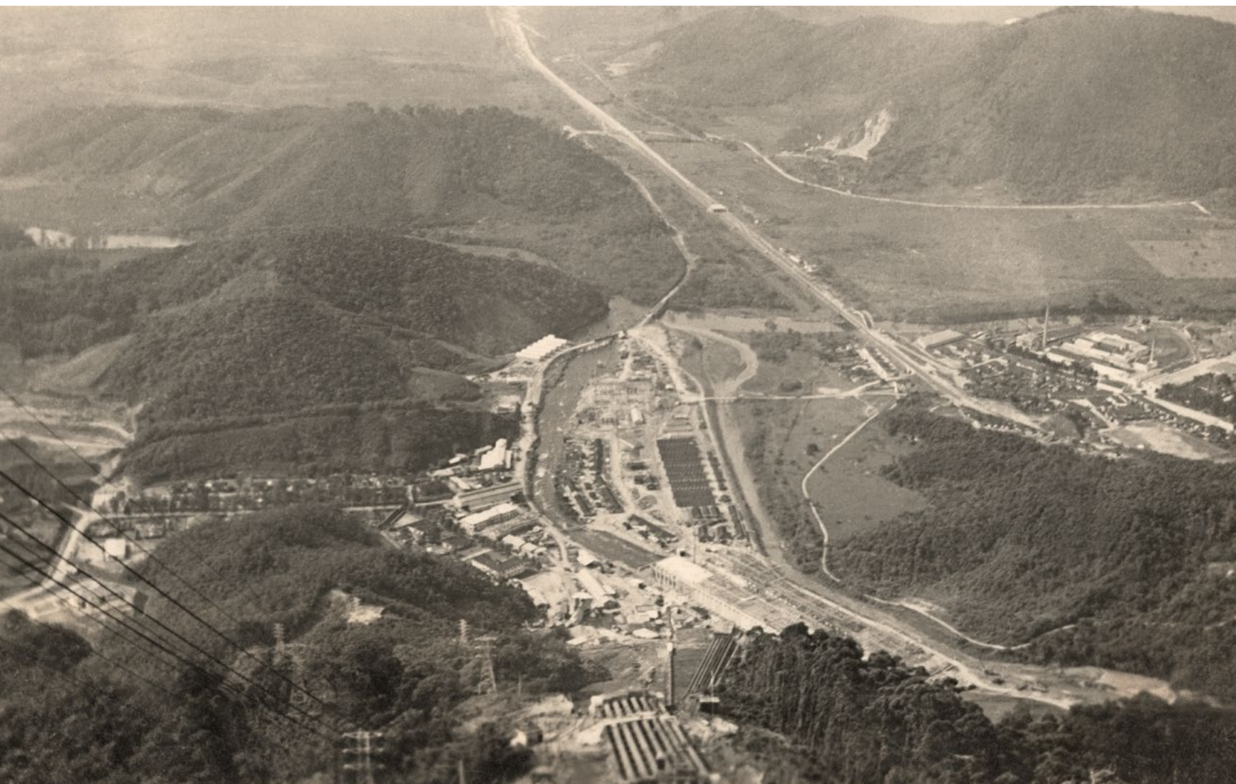
Usina de Cubatão depois das obras de expansão. Acima, foto tirada por Victor no alto da serra. Na página ao lado, vista da usina com sua casa de força, 1966.
