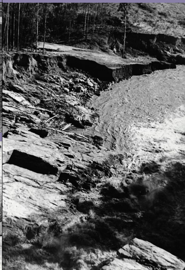
Situação em Limoeiro após o rompimento: no alto, vista da ombreira esquerda com detalhe do talude do montante da ombreira esquerda; talude de jusante (ombreira esquerda); brecha aberta na ombreira direita do maciço; à esquerda, vista de jusante da brecha aberta no reservatório; à direita, erosão devido ao galgamento do talude de jusante do maciço no seu lado esquerdo; e abaixo, ponte danificada à jusante de Limoeiro (antiga ligação Casabranca-Mococa).
