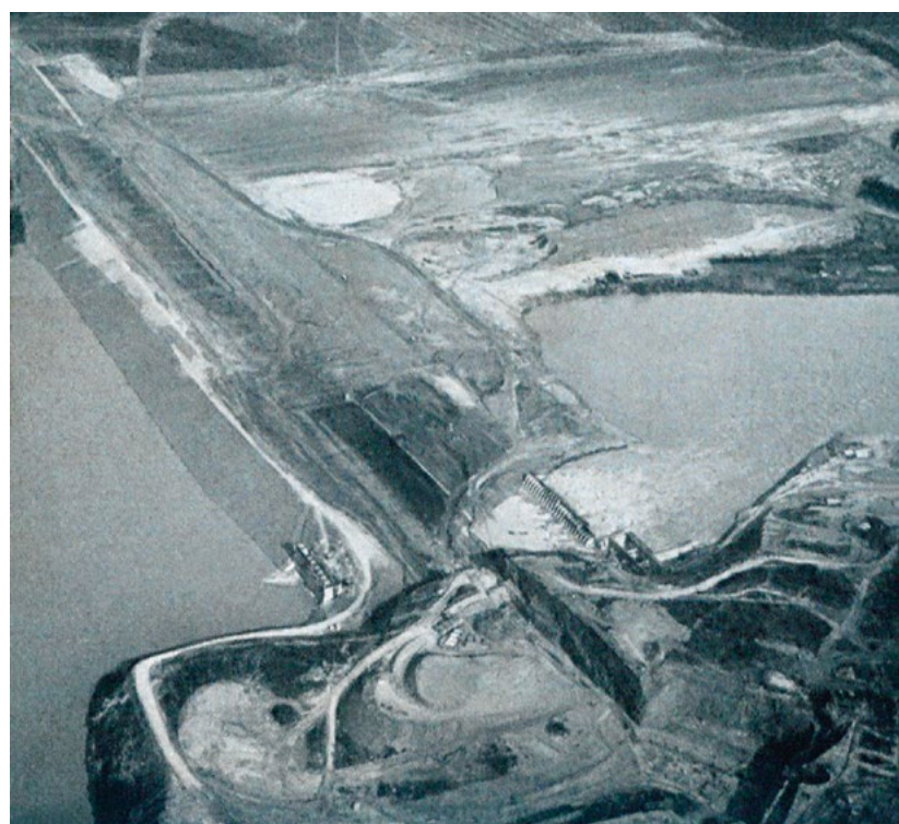
Vista aérea de Três Marias: construção das formas da casa de força e primeiro enchimento do reservatório.
