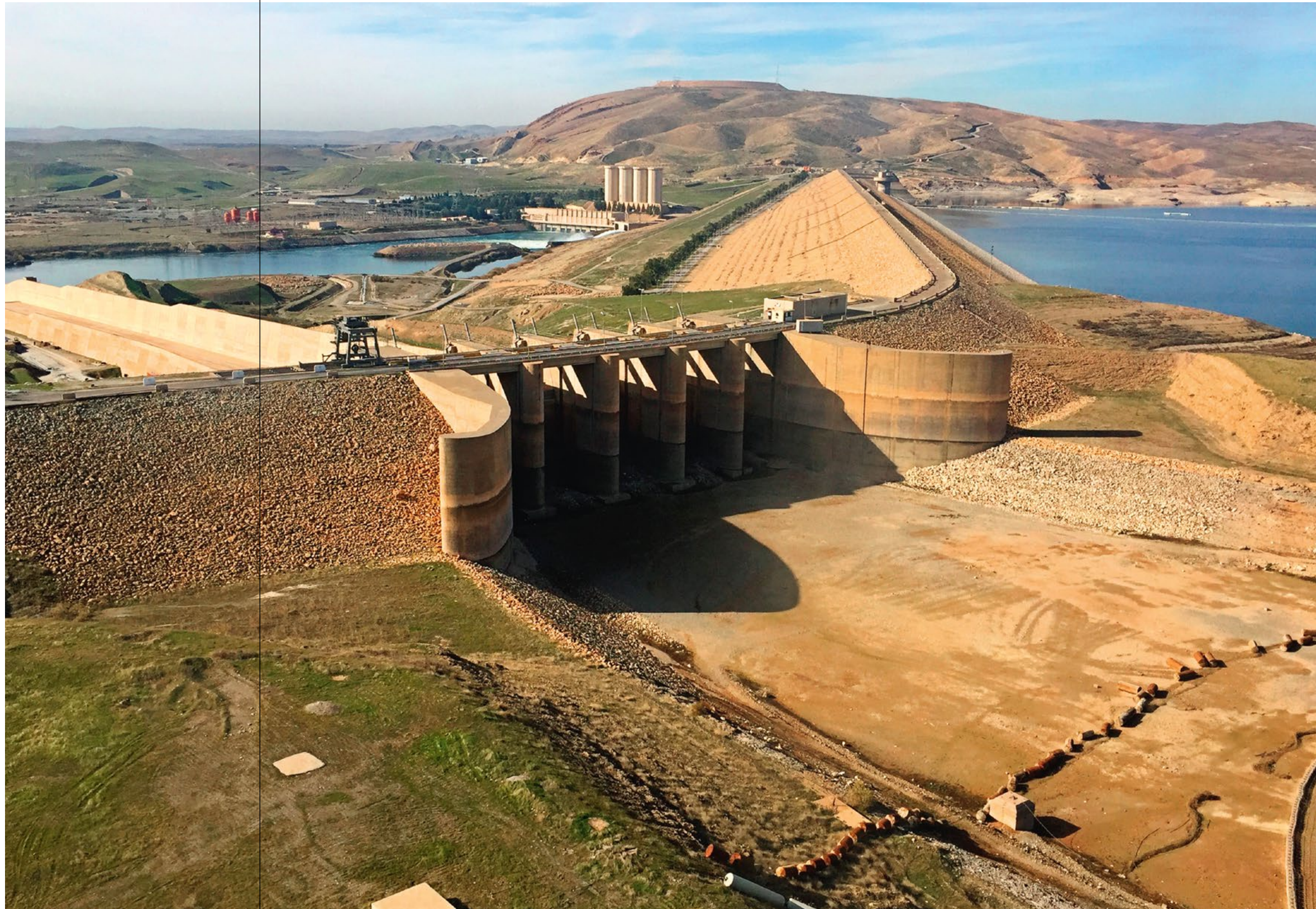
Na página ao lado, no alto, duas barragens em que Victor trabalhou como consultor: Apartadura, em Portugal, e Piedra del Águila, na Argentina. Acima, a barragem de Mosul, a maior do Iraque.
