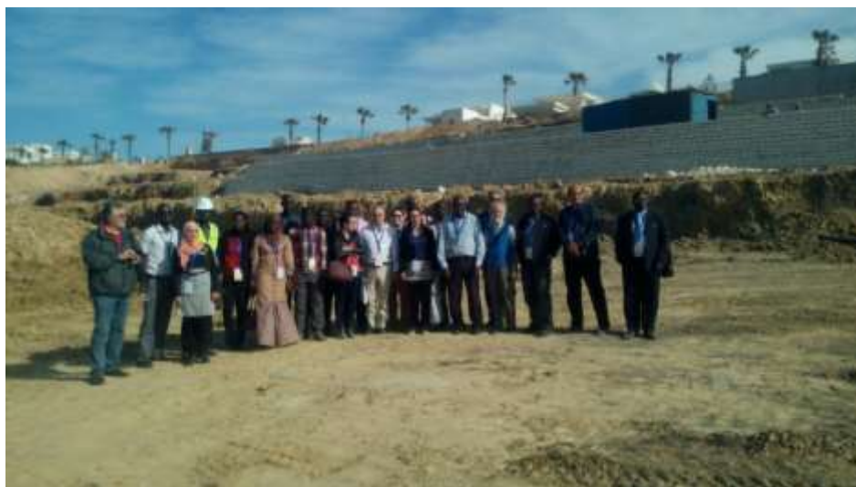
Photo 3 : Visite du chantier de stabilisation des falaises de Monastir
