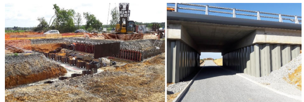
Figure 9. Road underpass in Juigné sur Loire, France (©ArcelorMittal).
