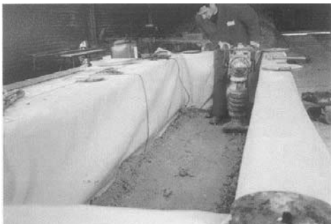
b) Compactage du matériau à la pilonneuse
