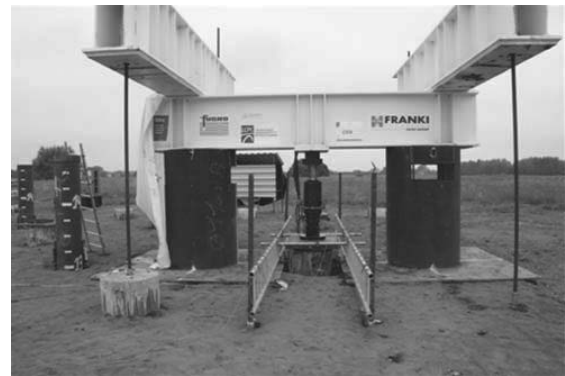
Figure 4 : Dispositif de chargement des pieux en compression.
