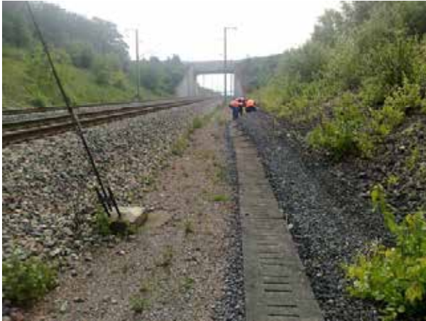
Photo 2: Exemple d'incident peu grave sur la LGV Est Européenne – glissement d'un talus de déblai avec soulèvement de la piste et du fossé
