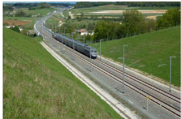
Photo 1: Traversée de la vallée de la Savoureuse sur la LGV Rhin-Rhône
