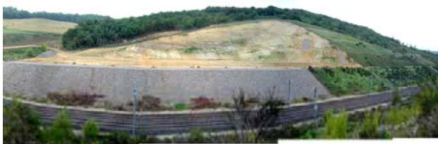
Photo 5 : Vue générale du déblai des Ayasses sur la LGV Méditerranée
