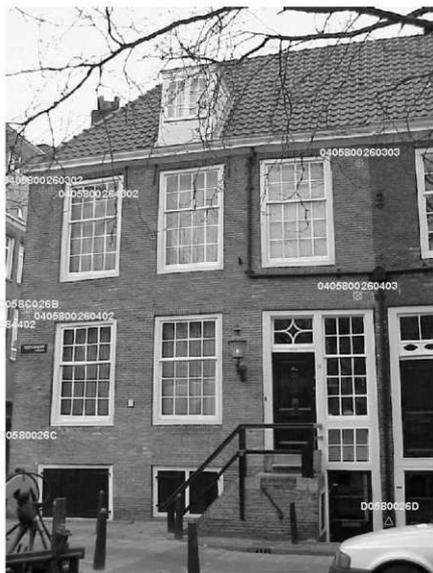
Figure 2 Weaverbuilding Vijzelgracht 26 with prism locations (picture Projectbureau NoordZuidlijn)
