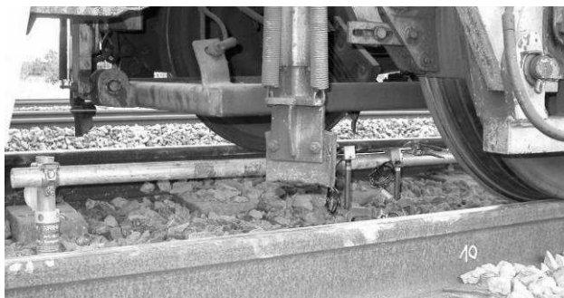
Figure 5. Vue de la charge appliquée sur les rails/traverses par le train de travaux SNCF.
