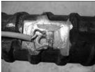
Fig.6 mise en place d'une jauge de contrainte sur une barre
