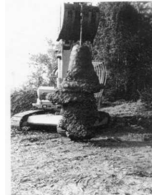
Fig. 3 colonne extraite - adaptation à la nature du sol
