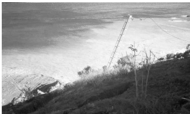
Figure 3 Vue sur les fissures de tractions
