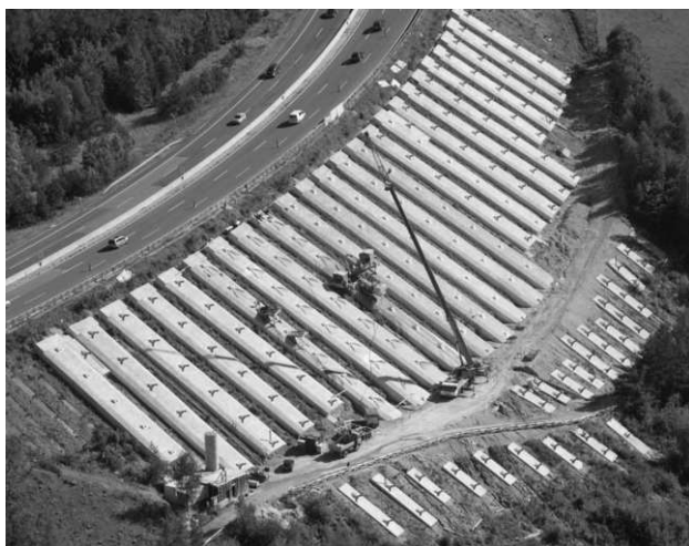
Fig. 12. Actual view of the site
