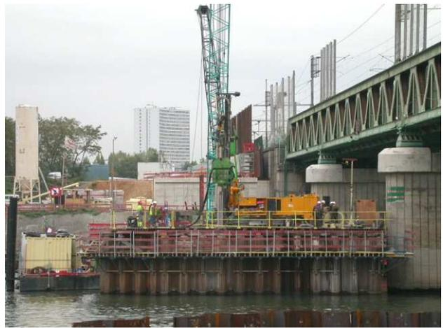
Figure 8. Vue des travaux d'installation des micropieux à partir du batardeau de la pile P2 (octobre 2004). On note la proximité de l'ancien pont de 1864.
