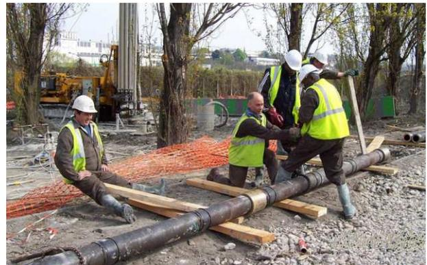
Figure 3. Vue de l'armature en cours d'assemblage
