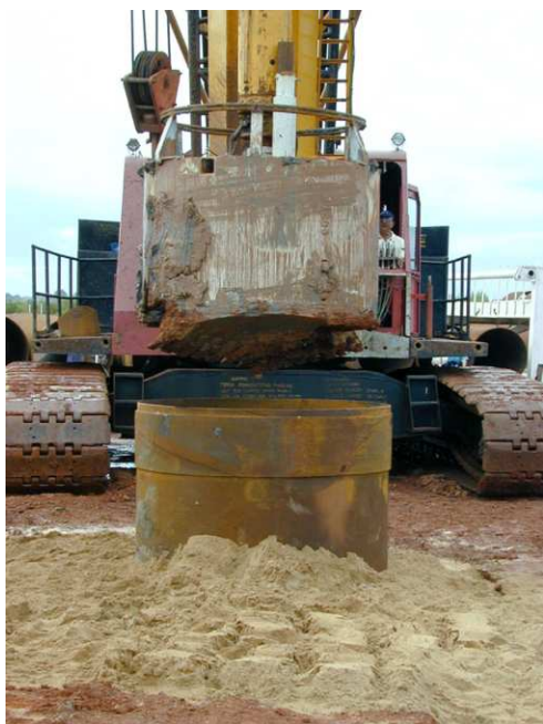
Figure 6. João Landim. Forage du pieu d'essai en cours
