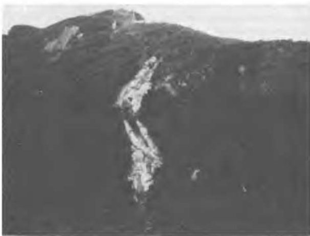
Figure 1. Cap slide over rock (Lugano Street, Petrópolis-RJ).
