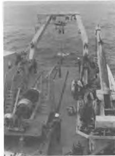
Fig. 4 - Mise en oeuvre du STACOR
