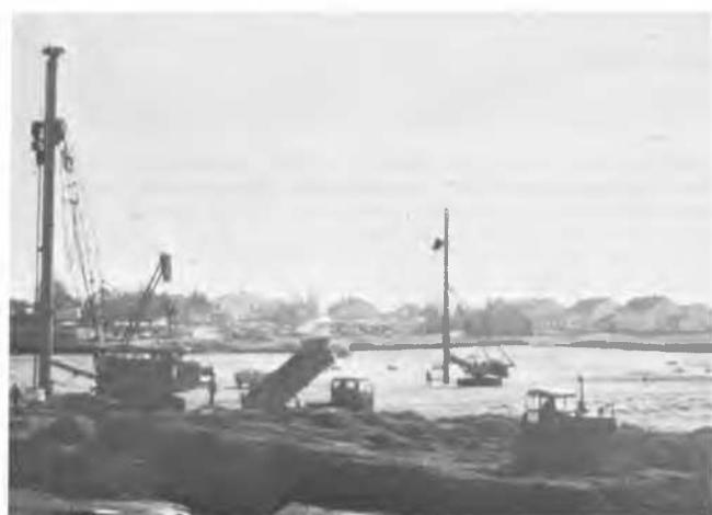
Fig. 3 Mise en place des drains
