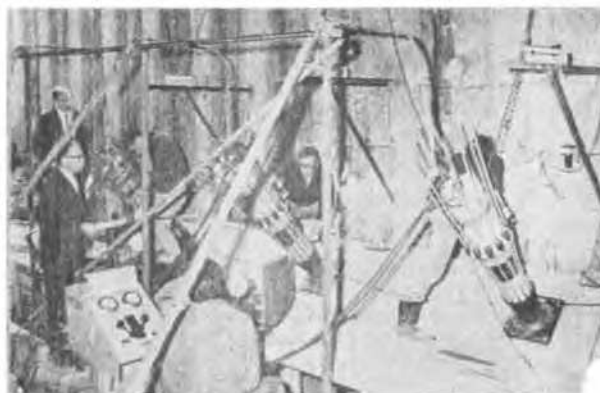
FIG. 2. ESSAIS PREALABLES DE 3 TIRANTS DE 175 tonnes chacun
