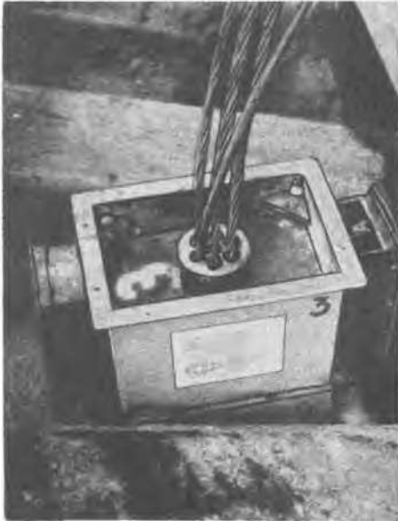
FIG. 5. CONTROLE DE LA TENSION DANS LE TEMPS CALE DE CONTROLE "RESPLAT" EN PLACE
