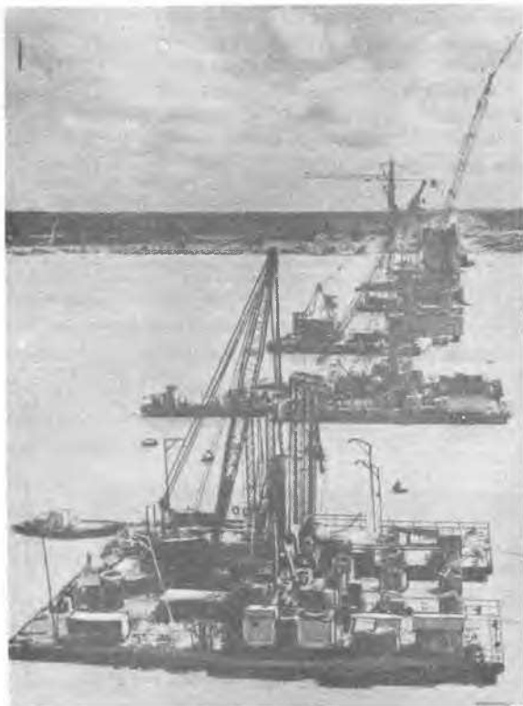
fig. 2 - vue générale du chantier -
