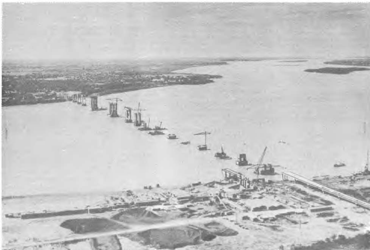
Fig. 9 - Vue générale du chantier
