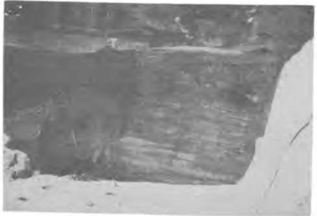
Cette photo montre l'état des fouilles devant recevoir les fondations de la station. Au premier plan , le fond de fouille et le front de taille sont constitués par du sable de FONTAINEBLEAU. En haut de la photo , on voit nettement le rocher qui est du grès de même étage géologique .
