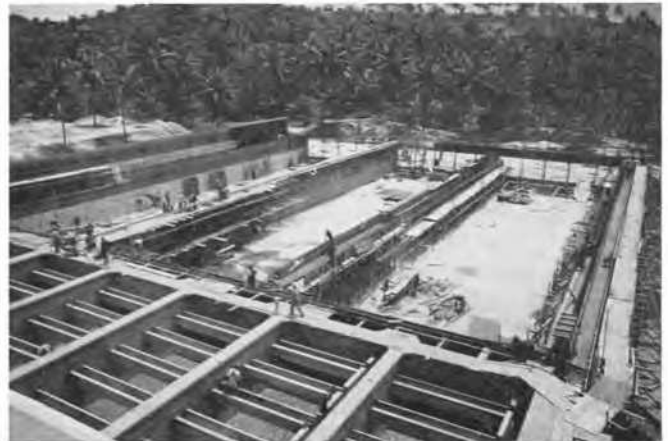
FIG. 6. Vue générale du chantier.
