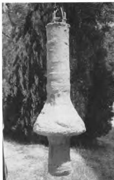
Fig. 2 Under-reamed pile. Pieux à bulbe.
