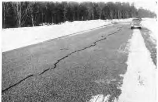
Fig. 1 Frost crack in a road near Ernsås, Sweden. Fissure sur la route d'Ernsås, Suède.
