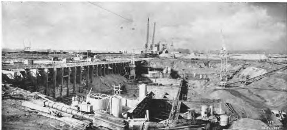
Fig. 8 Isola Serafini power station. View of excavations and abutment diaphragm. Usine d'Isola Serafini. Vue des fouilles et mur diaphragme de culée.
