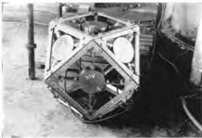
Fig. 1 Seven-face earth pressure gauge. Jauge à sept faces de mesure des contraintes.
