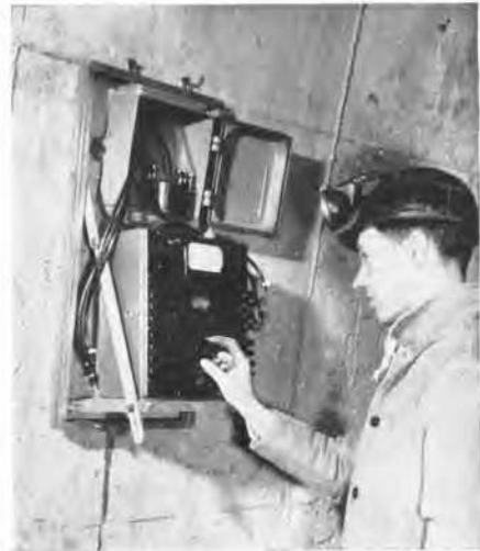
Fig. 11 Strain measurement equipment in place underground. Mesure des déformations au fond de la mine.
