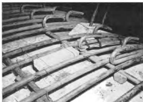
Fig. 8 Measuring element behind shuttering before grouting. Élément de mesure derrière le coulage avant l'injection du béton.
