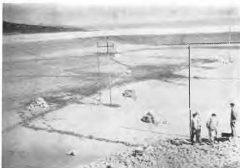
Photo 1 Pond 'B' (clay blanket and measuring devices). Réservoir 'B' (tapis d'argile et appareils de mesures).
