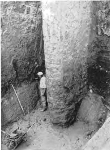
Fig. 5 Digue de St-Luce sur le fleuve Fine (diaphragme plastique sous le noyau de la digue, épaisseur : 0,80 m ; profondeur maximum : 15 m). Extrémité rive gauche du diaphragme.
