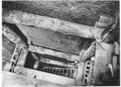
Fig. 6 Digue de St-Luce, sur le fleuve Fine (diaphragme plastique sous le noyau de la digue : épaisseur : 0,80 m ; profondeur maximum : 15 m). Puits mettant à nu l'une des faces du diaphragme (partie supérieure de la photo).
