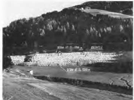
Fig. 4 View of a consolidated stretch of slope. Vue d'une zone à talus consolidés.
