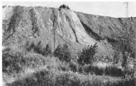
Fig. 3 Déversement de crasse dans la zone de glissement. Dumping slag in the slide area.
