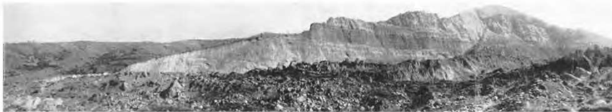
Fig. 1 Landslide panorama. (The rubble slope on the toe of the break-off wall proceeds from blowing up the cap of the hill after failure.) Vue panoramique du glissement. (Les débris au pied de la crête rompue proviennent du sautage du sommet après le glissement.)
