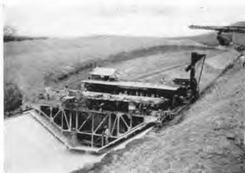
Fig. 3 Lining Machine. Machine pour la mise en place du revêtement.
