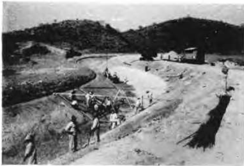
Fig. 8 Trimming to line swollen section. Mise au profil d'une section gonflée.
