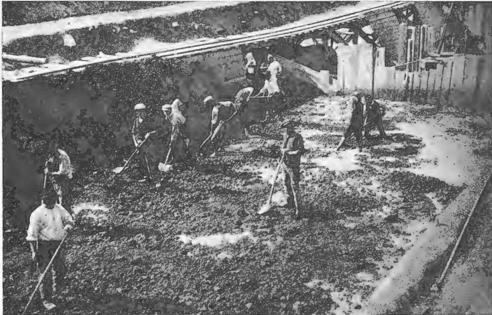
Fig. 5 Filling the cut-off trench Remblayage de la tranchée de parafouille
