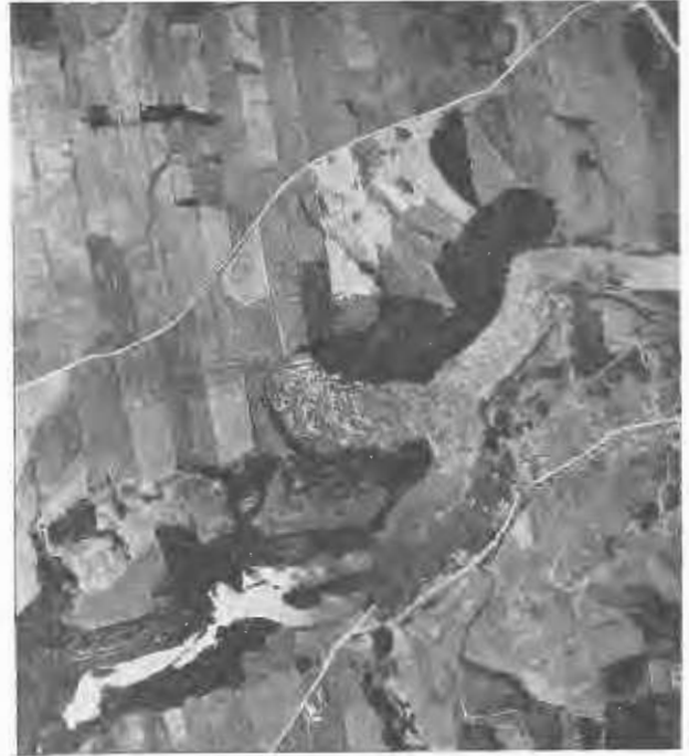
Fig. 4 Vue aérienne du second éboulement de Rimouski Aerial view of second slide of Rimouski
