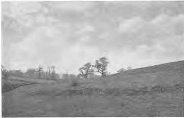
Fig. 3. Childerditch No. 1. 10\frac{1}{2} degree slope, active slip Talus à 10\frac{1}{2} degrés, glissement en course
