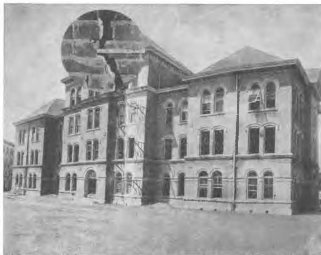
Fig. 1 An Example of a Partition Wall Crack for Foster Hall Fissure dans un mur de refend à Foster Hall
