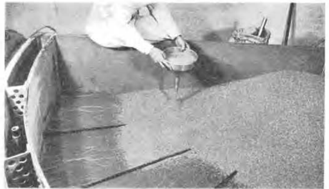
Fig. 2 Model of the Horizontal Filterwell. Filling in of the Pervious Material Modèle de collecteur horizontal au moment de l'addition de l'aquifer
