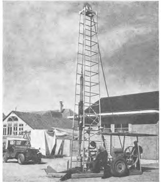
Fig. 2 Press-Ram-Penetrometer at Work Sonde de pénétration en action
