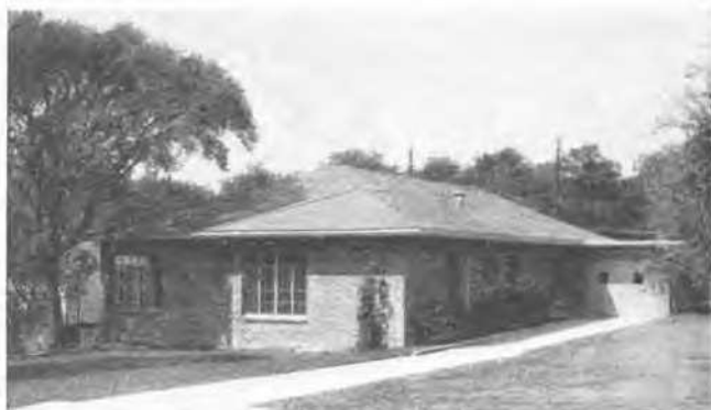
Fig. 1 House No. 1. Honeycombed Foundation Maison No 1. Fondation alvéolaire
