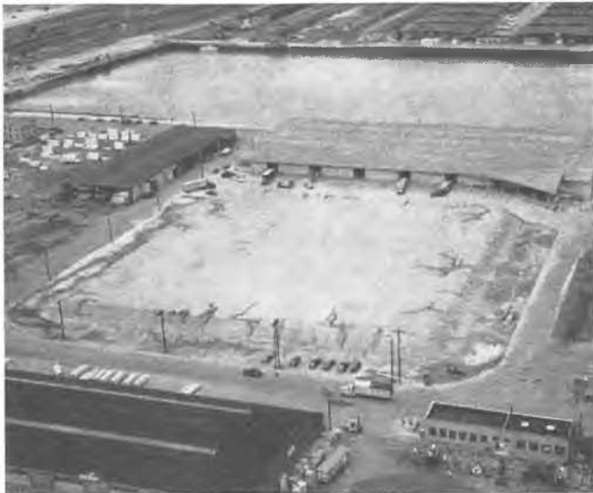
Fig. 8 Aerial view of Surcharge Fill on Building No. 1 at Port Newark Remblai de surcharge du bâtiment No 1 à Port Newark, vue à vol d'oiseau
