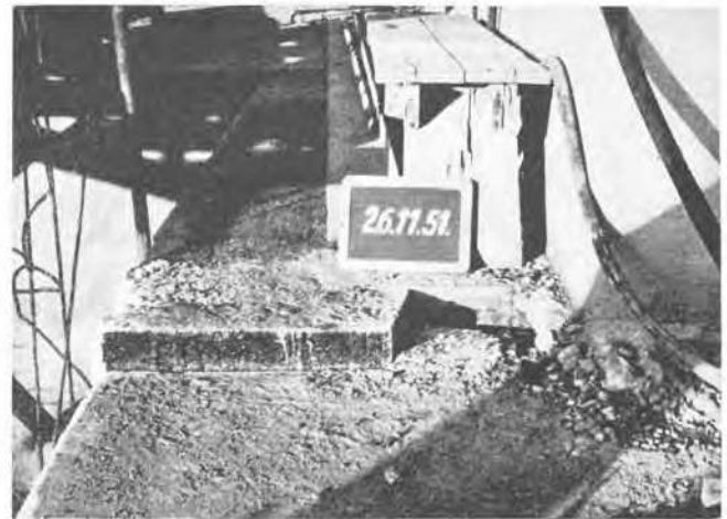
Fig. 9 Soulèvement de l'usine par rapport à la maçonnerie avoisinante Raising of the Power Station in Comparison with the Surrounding Stone Work
