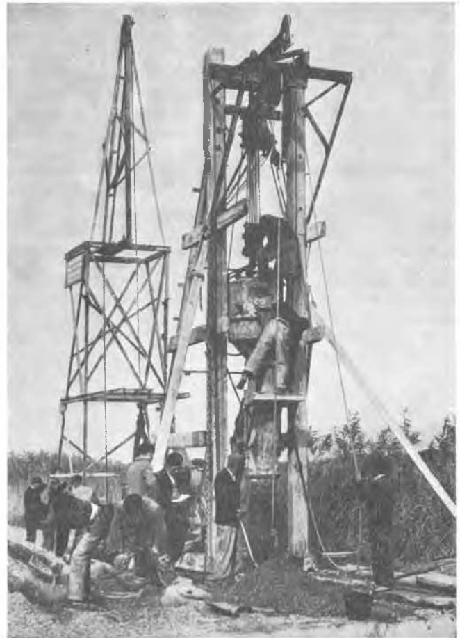
Fig. 2 Bétonnage d'un pieu Cement Mixing of a Pile
