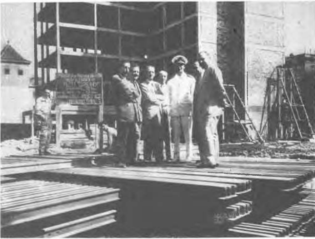
Fig. 6 Essai de charge à Barcelone Loading Test in Barcelone
