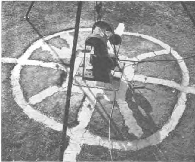
Fig. 11 Installation d'essais pour 200 t Test Arrangement for 200 t
