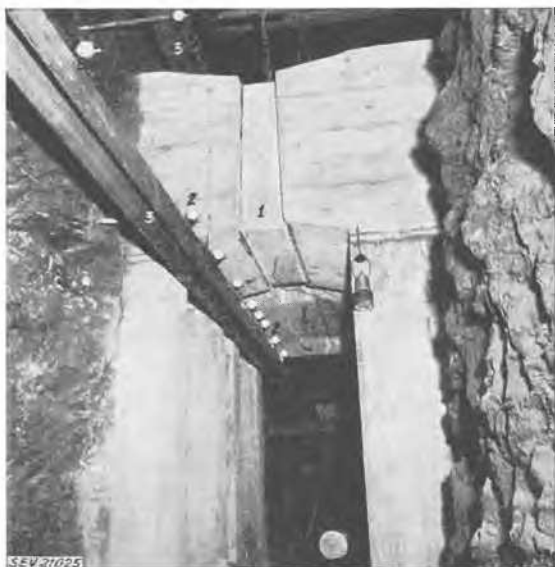
Fig. 16 Photographie des vérins capsulaires avec le dispositif de mesure des déformations Measurement of the Elastic modulus of the Rock. Photograph of the Loading Cells (Capsular Jack) (1) with the Arrangement for Measuring Deformations (2)
