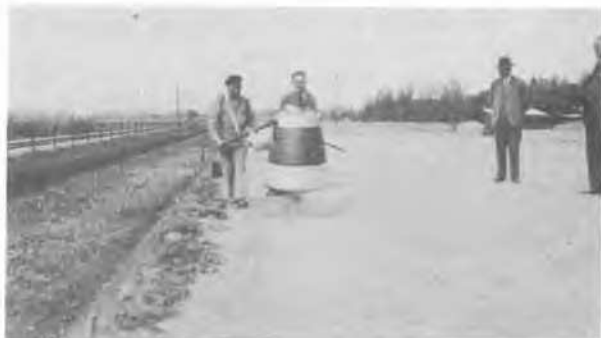
b EXPLOSION RAMMER EXPLOSIONSSTAMPFER
