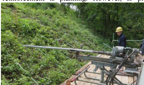
【Installation of SDPR】
