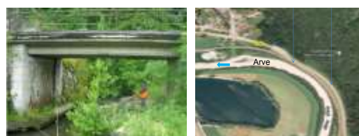
Figure 6. Deux sites 'pilotes' : (à gauche) pont ferroviaire sur le Moulègre, (à droite) remblai-digue le long de l'Arve.
