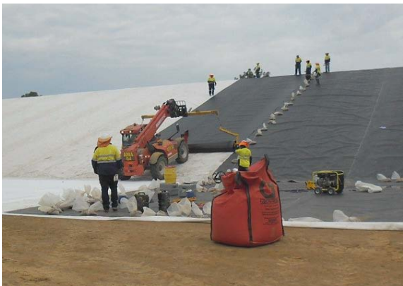
Fig. 2 Geomembrane Placement
