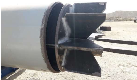
Figure 7. Mise en place d'un diaphragme dans un tube métallique
