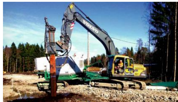
Figur 7 Masstabilisering med bindemedelsvagn (Foto: Keller Grundläggning)
