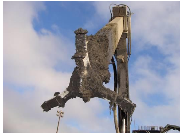
Figur 6 Inblandningsverktyg (Foto: Keller Grundläggning)
