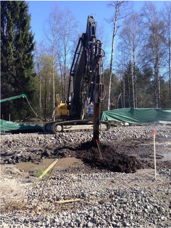
Figur 8 Masstabilisering (Foto: Keller Grundläggning)
