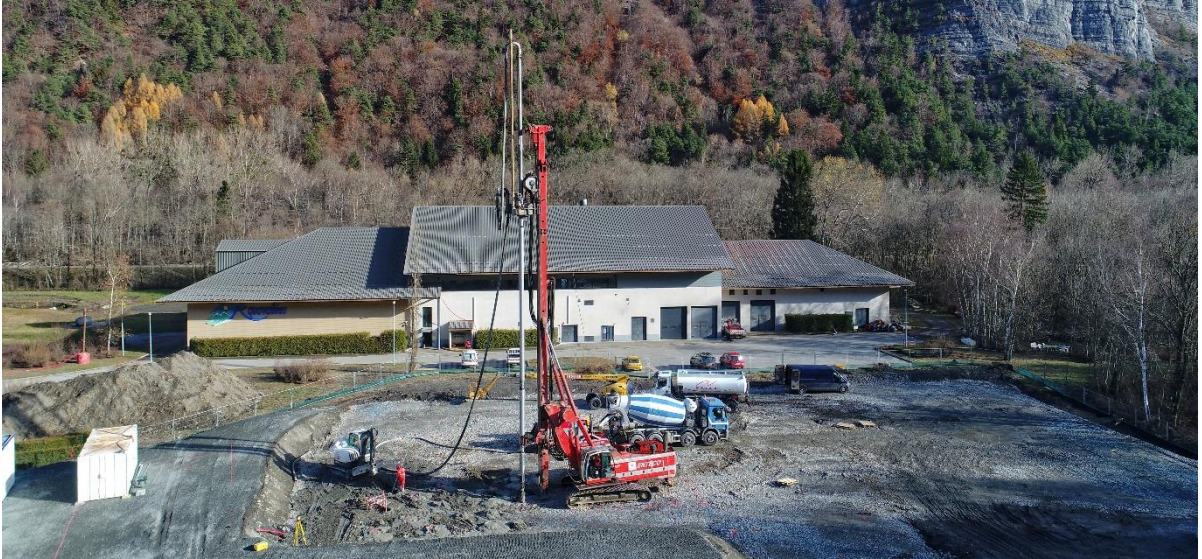
Figure 11. Atelier MENARD d'inclusions rigides pour la réalisation de la partie inférieure de la CBM
